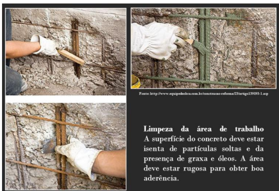
Fig 10 – Superfície de concreto após apicoamento
